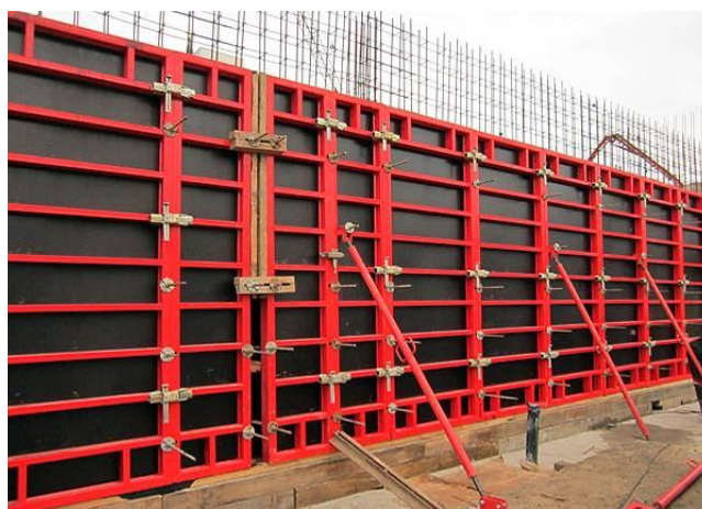
Рис. 1. Крупнощитовая опалубка DELTA
