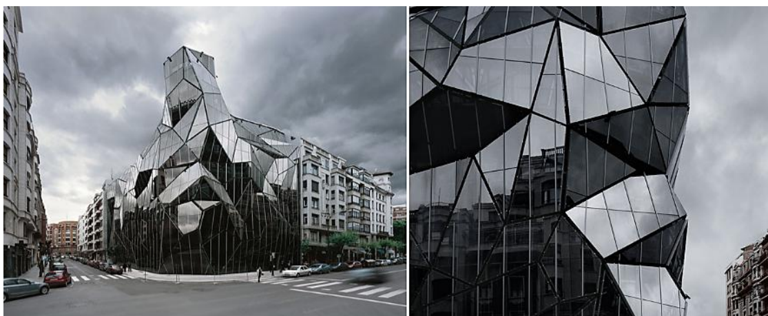
Рис. 4. Дом ста лиц (Edificio prismático), или дом призма, Штаб-квартира Департамента здравоохранения Басков, Бильбао, Испания
