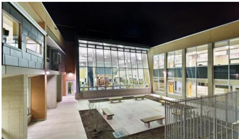
Рис. 2. Thomas L. Wells Public School, Торонто, архитектурная фирма Baird Sampson Neuert Architects, внутренний дворик
