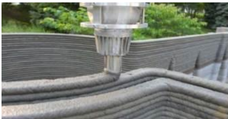
Рис. 2. Процесс построения по технологии ConcretePrinting
