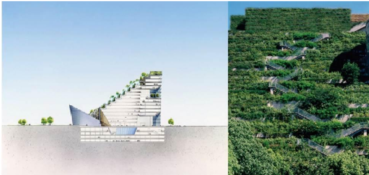
Рис. 3. Культурный центр ACROS, в котором использована технология «теплых» стен посредством вертикального озеленения
