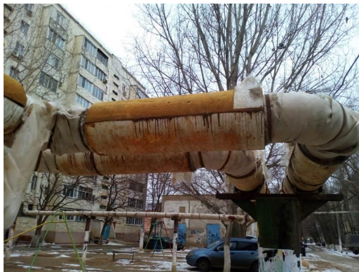
Рис. 4. Участок с качественной изоляцией
