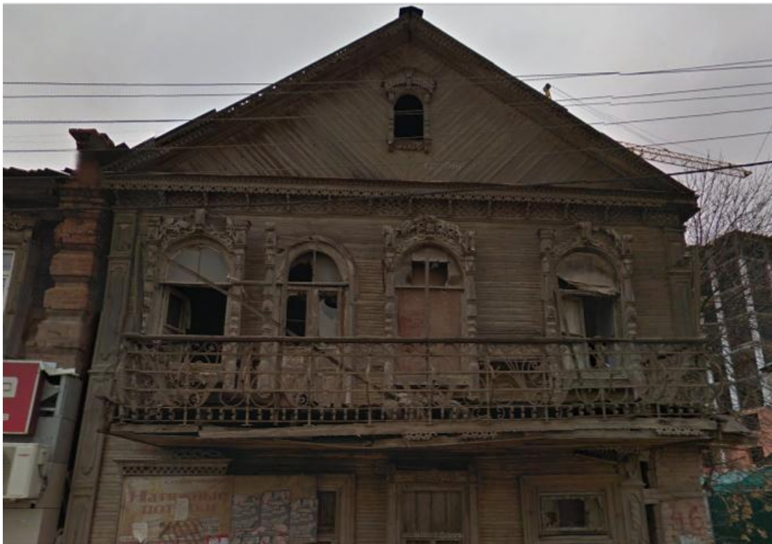
Рис. 9. Жилой дом по ул. Калинина, 45
