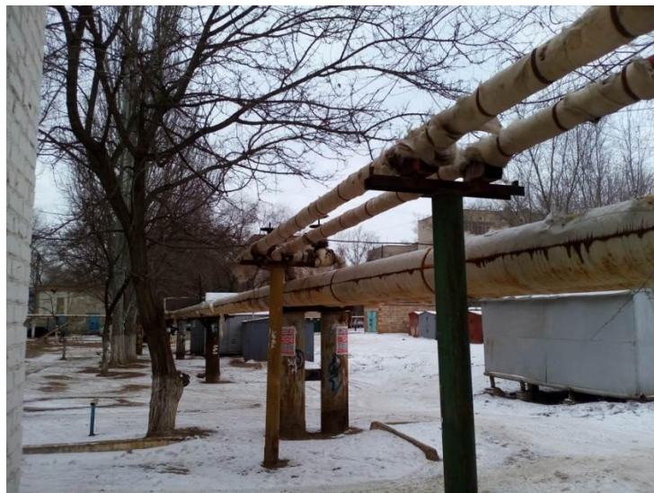
Рис. 3. Участок с качественной изоляцией
