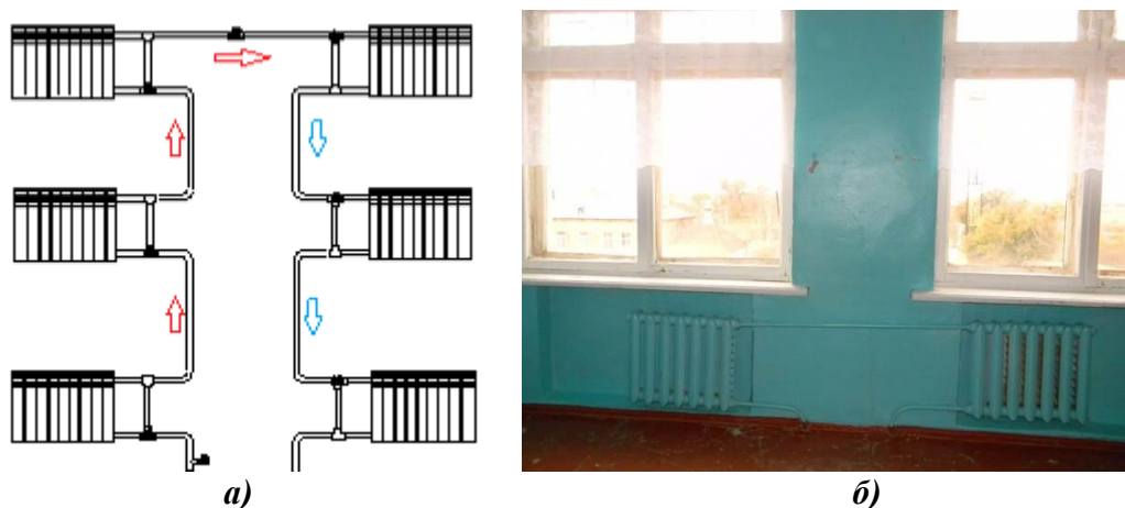
Рис. 3. Схема системы отопления на 4 этаже школы: а) схема работы; б) перемычка радиаторов на 4-ом этаже
