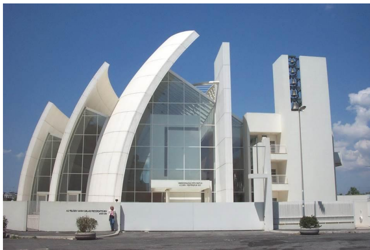
Рис. 1. Церковь из сборного железобетона в Риме
