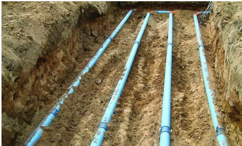
Рис. 1. Грунтовый теплообменник
