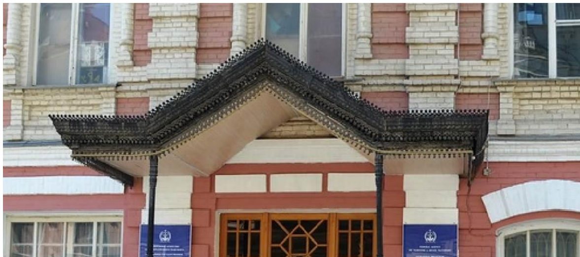
Рис. 6. Козырек над входом
